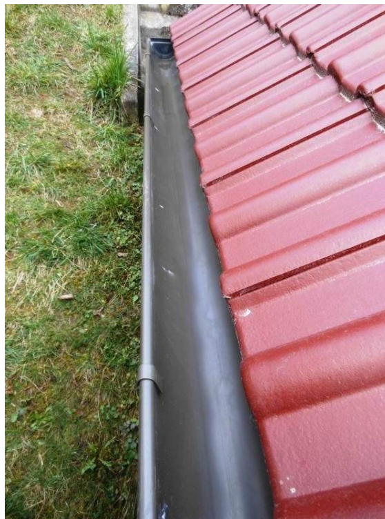
Gereinigte Dachrinne am 24.03.2016
