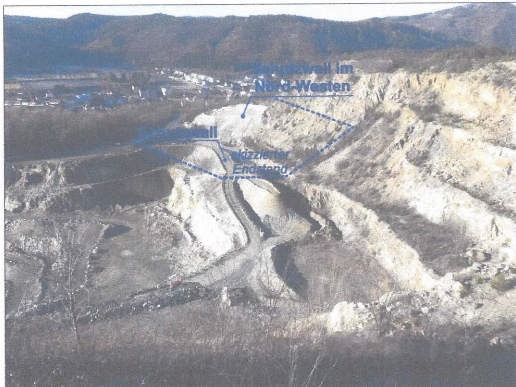
Blickrichtung: Nord-West Materialvorschüttung aus Richtung West („Schutzwall im Nordwesten“); Aufbau von unten nach oben; Schutzwall funktionstüchtig Bild 12 Aufnahmedatum: 18.12.2017
