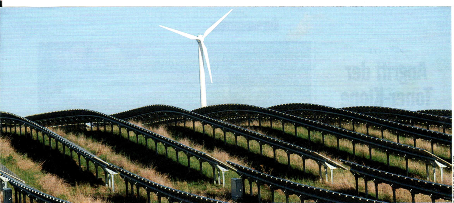
Photovoltaikanlage, Windrad in Schleswig-Holstein: „Das klingt schnuckelig“
